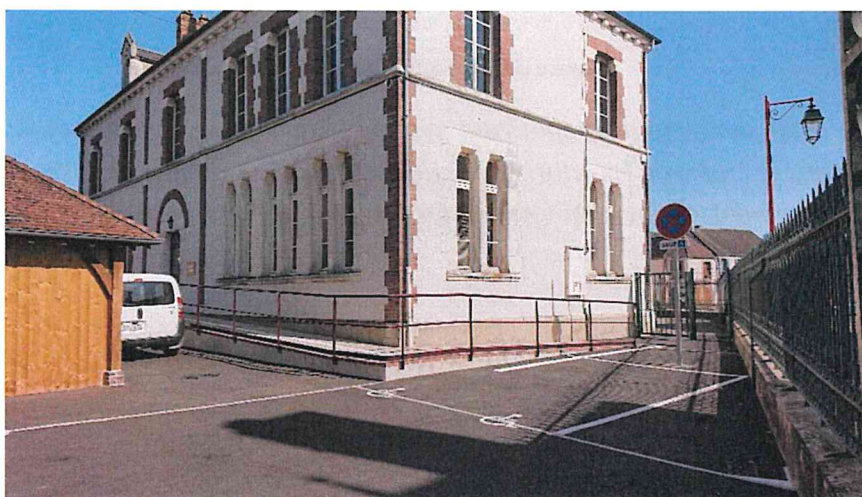
Figure 36 : Accès PMR de la Mairie
